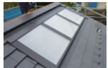
屋根一体型高効率真空集熱器
